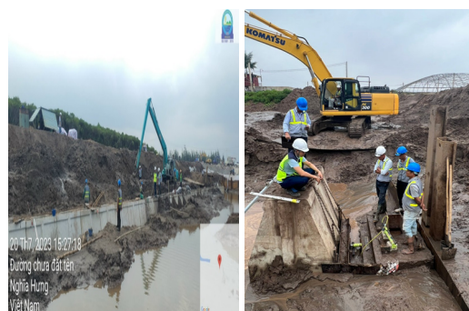
Hình 3. Thi công bờ kênh và thử tải tại hiện trường
