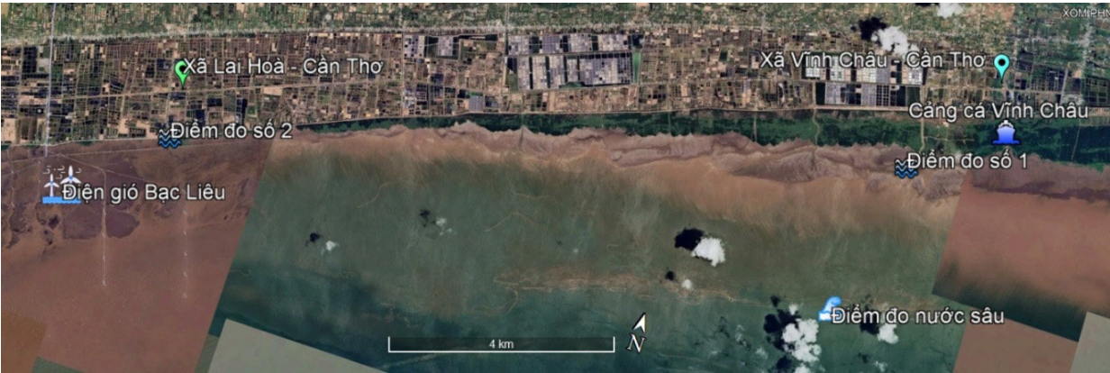
Hình 5. Đoạn bờ biển phường Vĩnh Châu và xã Lai Hòa (Cần Thơ), vị trí khảo sát dự kiến ven biển và trên bãi bồi
