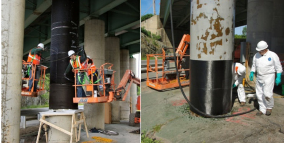
Hình 3. Sửa chữa trụ cầu ở Bangor, Maine, Mỹ bị hư hỏng do ASR sử dụng lithium nitrat và bọc cột bằng CFRP [19]
