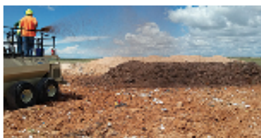
Hình 1. Phủ bãi chôn lấp rác dùng Posi - shell
