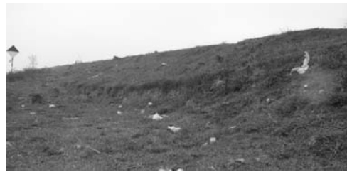
Hình 1. Sự cố trượt mái đê phía sông tại K1+070 đê tả Đuống - chụp tháng 2/2014
