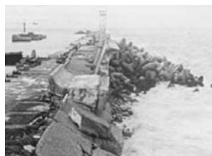
Hình 1. Hư hỏng của Đê chắn sóng Sines (Bồ Đào Nha) năm 1978
