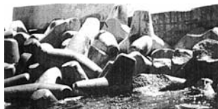
Hình 3. Hư hỏng của Đê chắn sóng Tripoli (Libya) năm 1982
