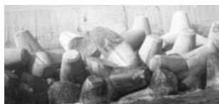
Hình 2. Hư hỏng của Đê chắn sóng Arzew El-Djedid (Algeria)
